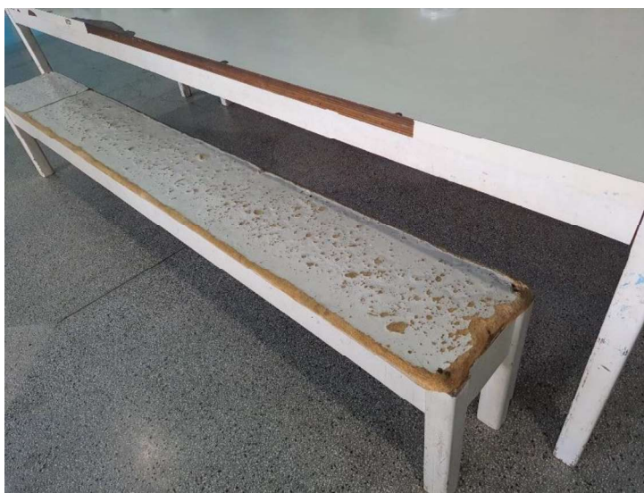
Banco do refeitório escolar em péssimo estado de conservação
