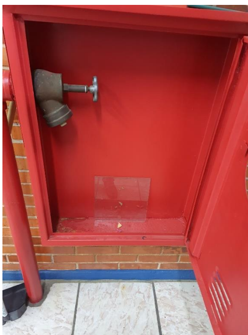
Ausência de mangueira de combate à incêndio
