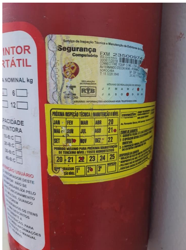
Extintor de incêndio vencido
