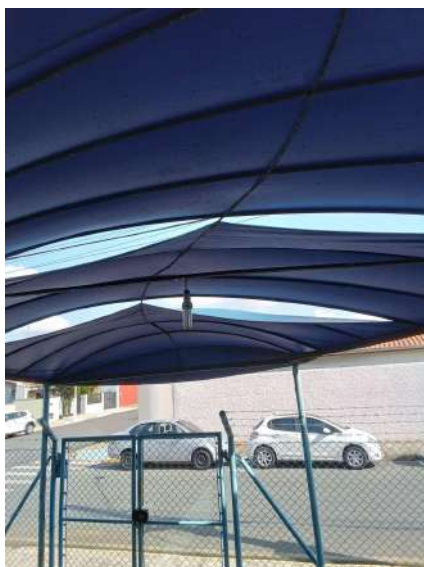
defeitos no toldo
